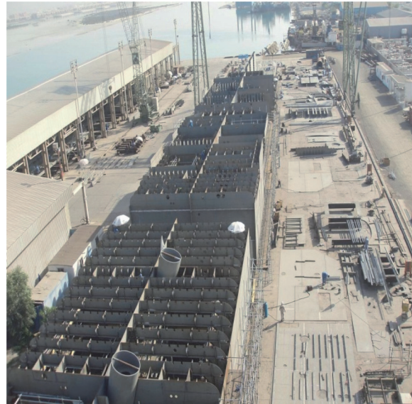
Abbildung 18: Vorfertigung der Pontons einer Bohrinself (Quelle: Nöll-IMAC/MCC, Abu Dhabi)
