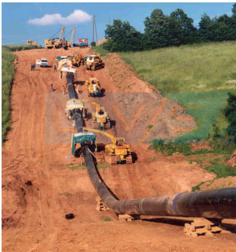
Abbildung 35: Baustelle – Verlegung einer Erdgastrasse in Deutschland
