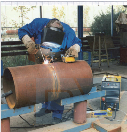
Abbildung 4: Lichtbogenhand-Fallnahtschweißen im Freien
