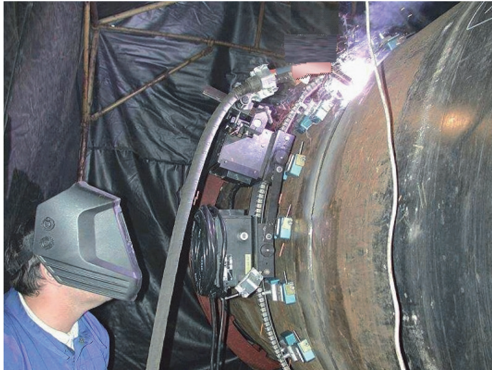
Abbildung 14: MAG-Orbitalgerät (Quelle: BUGO)
