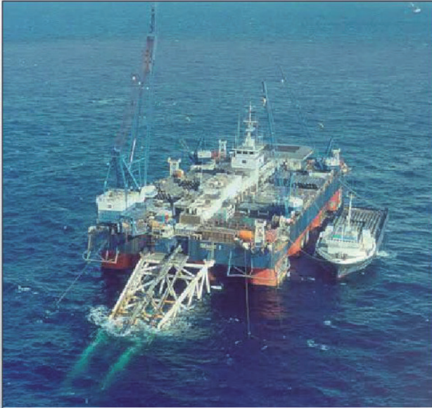
Plattform zum Verlegen von Offshore-Leitungen Foto: EUROPIPE GmbH, Ratingen
