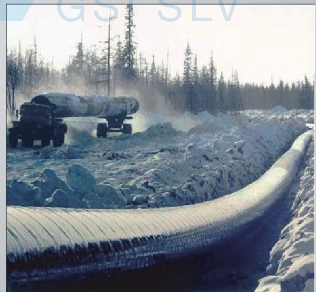
Pipelines in arktischen Regionen Foto: EUROPIPE GmbH, Ratingen
