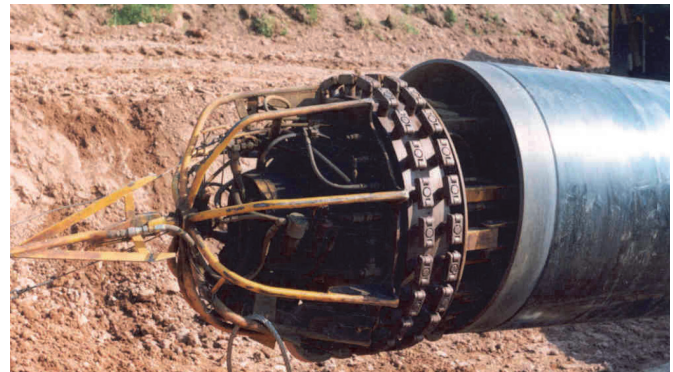
Abbildung 38: Innenzentrier-Vorrichtung für die Fallnahtschweißung von erdverlegten Großrohren
